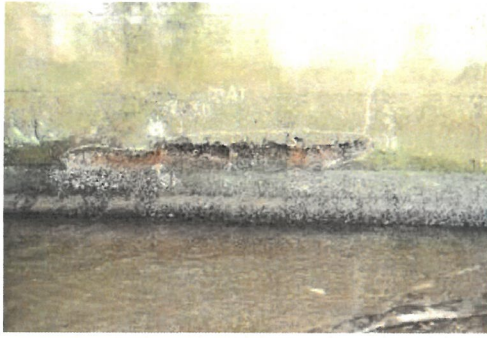
15. 東今田橋：RC中実床版橋 (橋長：3.80m、1981年竣工)
