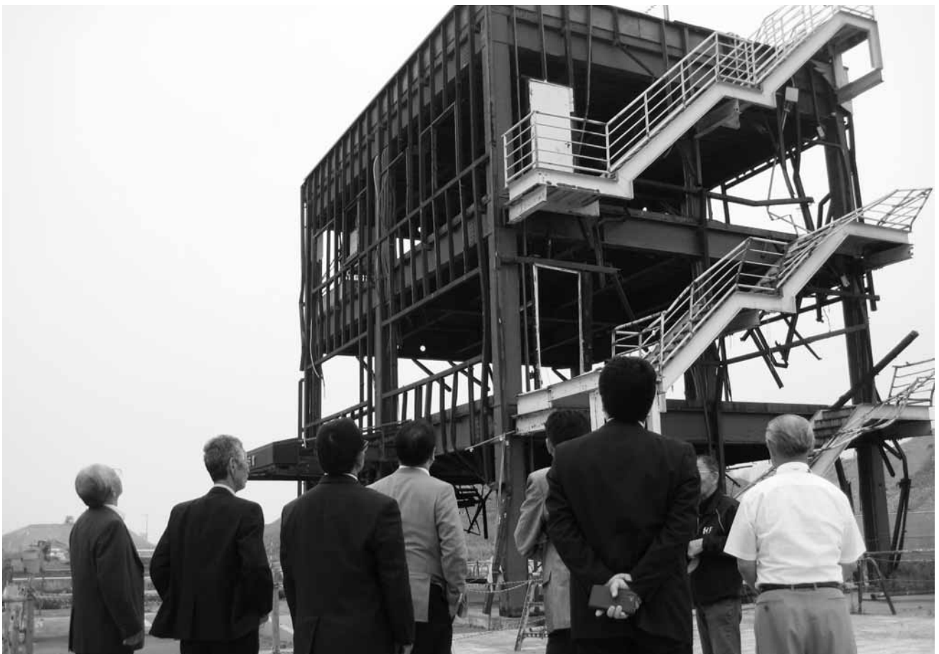
▲ 南三陸町 — 保存が決まった防災庁舎 —
