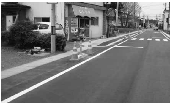
背戸谷地内の改修された歩道
