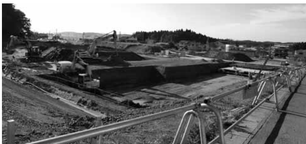
▶幼保一体化施設用地の造成工事
