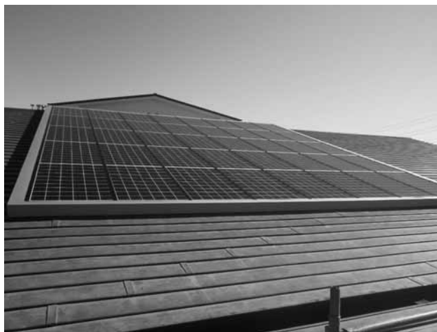
地域福祉センター 太陽光発電設備工事3174万円
