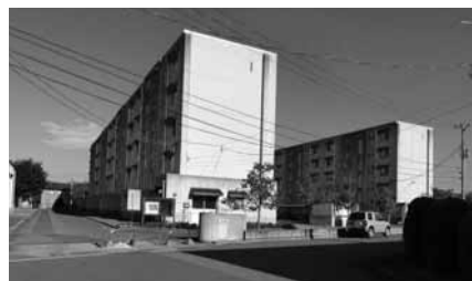
▲2棟で80戸のみのわ団地
