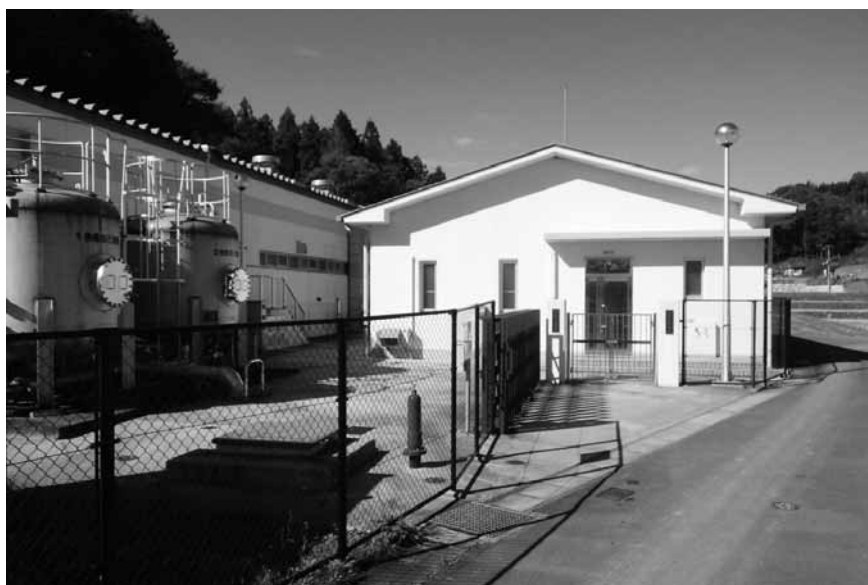
▲ 1日300トンの浄水をつくる太田輪浄水場
