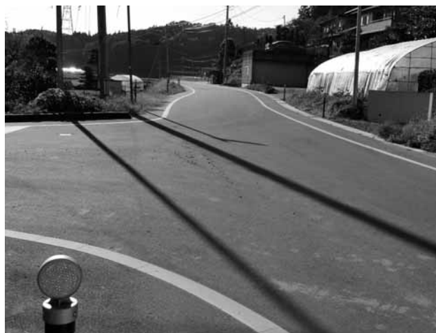
箕輪・袖山線道路改良舗装工事 平成27年度は3400万円
