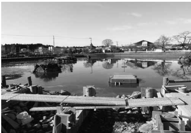
▼改修工事中の八紘園の木橋
