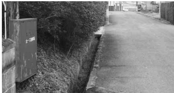
宿裏地内の古い側溝
