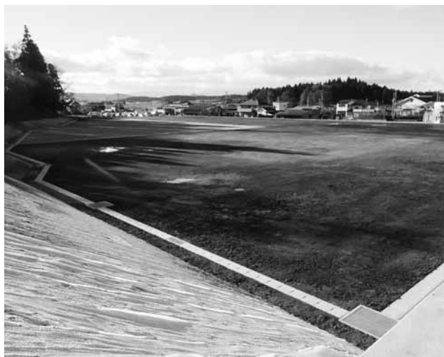
幼保一体化施設敷地造成工事 1億5500万円
