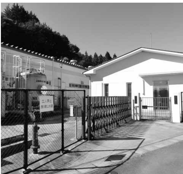
▲安くて安全な水をつくっている町の水道施設
