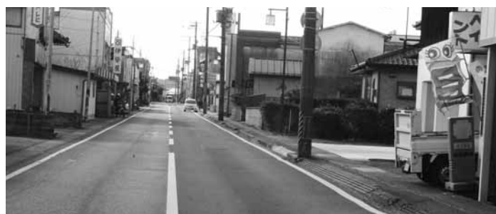
段差が目立つ歩道
