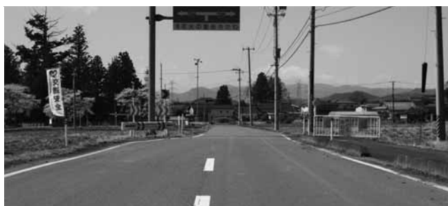
130mが未整備の町道
