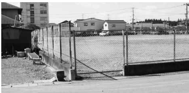
JT跡地に再度つけられたフェンス
