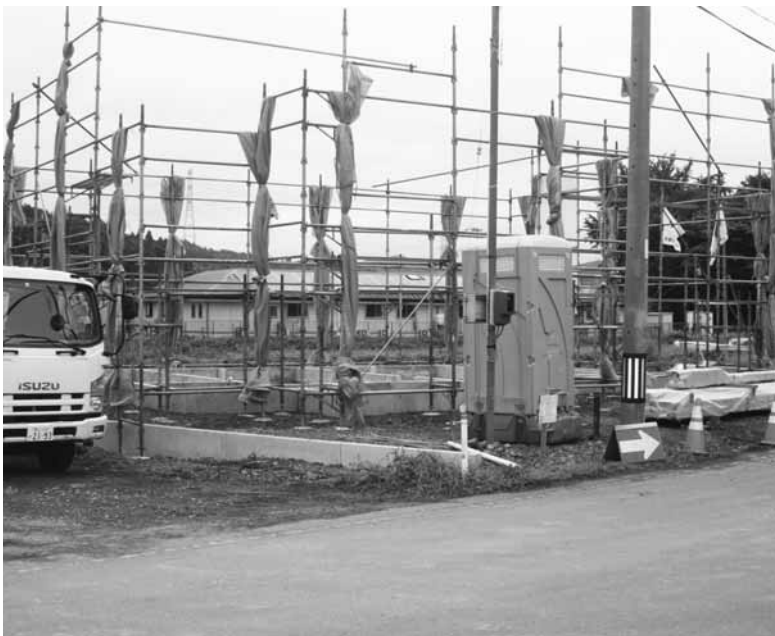
建設中の滝輪集会所
