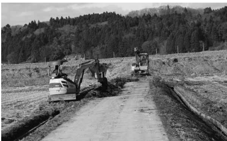
滝輪地内の水路復旧作業
