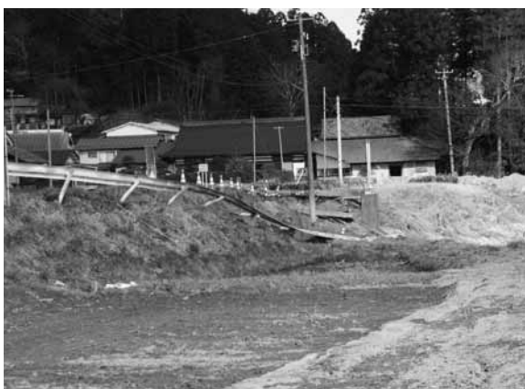
被災した滝輪前の県道
