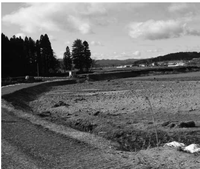
堤防が決壊して被災した小貫地内の水田
