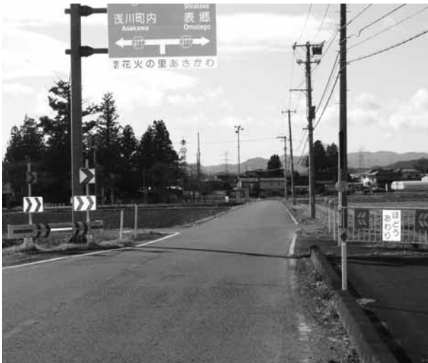
130mが未改修の町道
