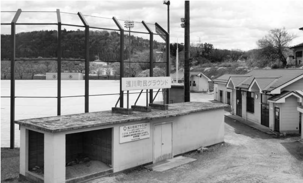
冠水した施設
