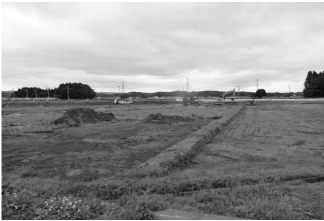
復旧工事が進む福貴作西地区
