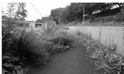
関東精工前の歩道
