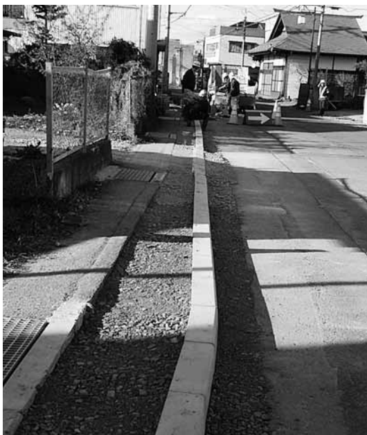
整備工事が始まった歩道
