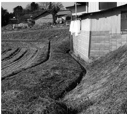
島田地内排水路状況
