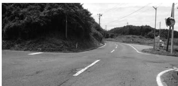
左側（仁公儀）からの見通しが悪い交差点
