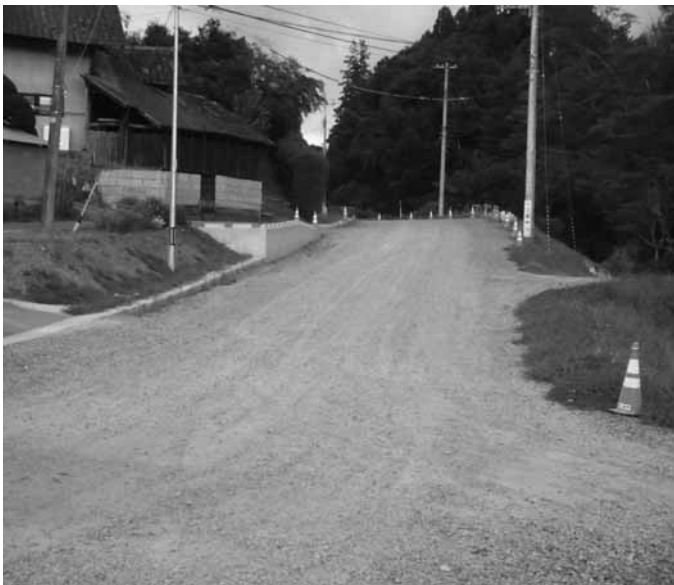
工事中の破石地内
