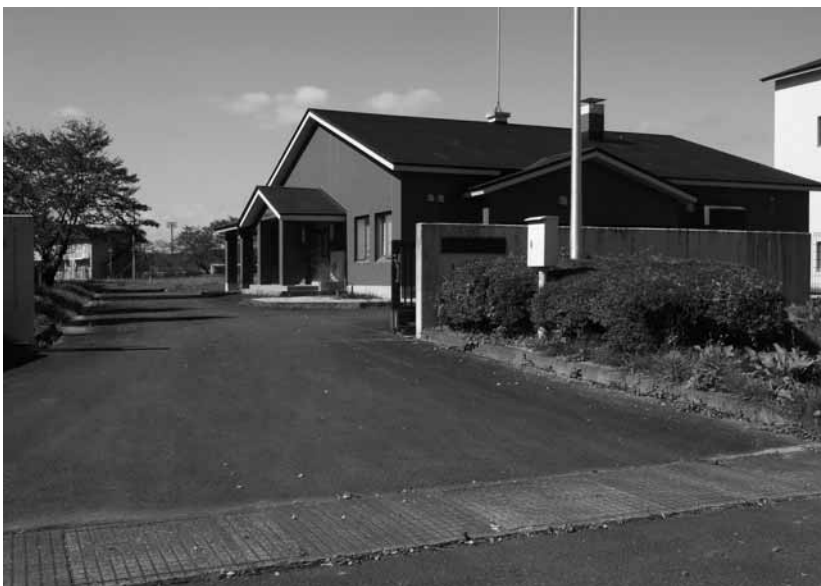
浅川浄化センター
