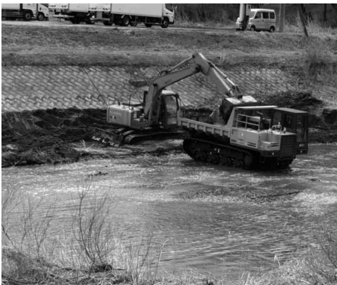
弘法山付近で進められている堆砂除去
