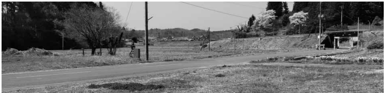
関沢地内の水郡線ガード付近
