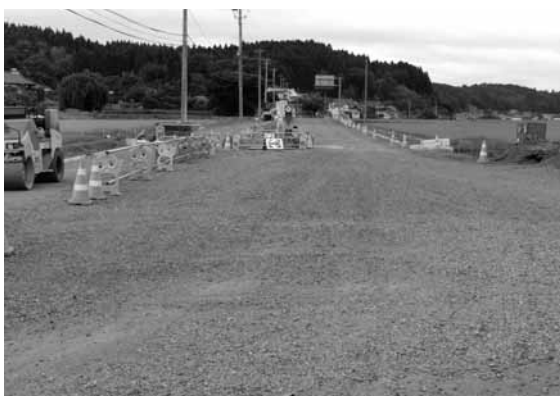
辺地債を活用した染小貫線工事
