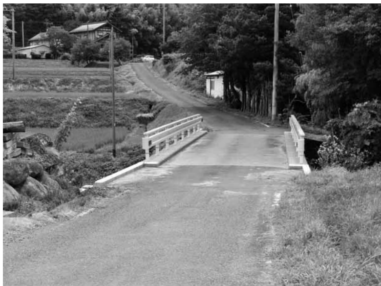
改修が終った大草川橋
