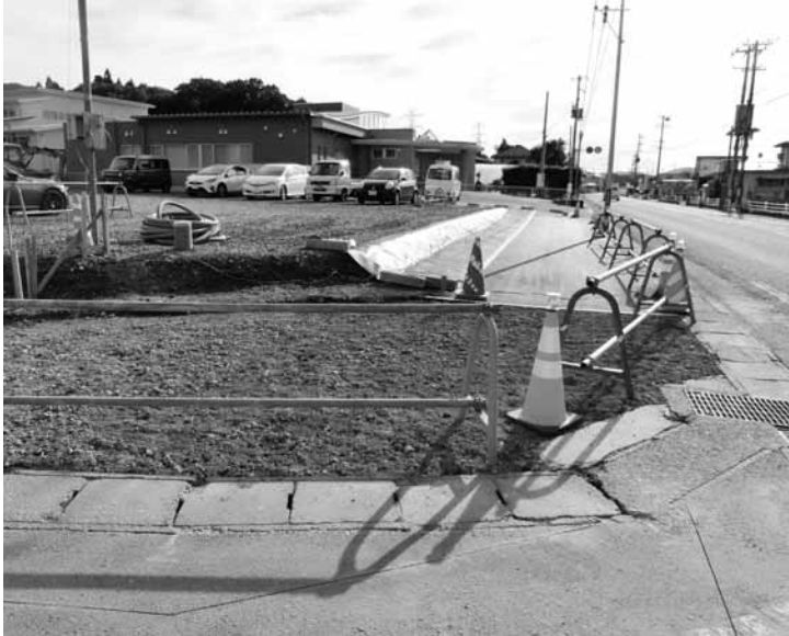
歩道の整備工事が始まりました
