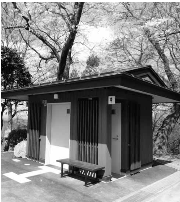
建替完成したトイレ
