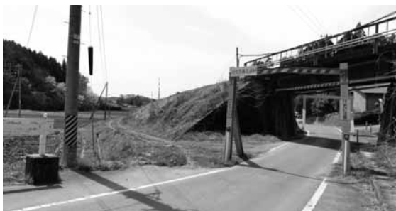
大型車が通れないガード
