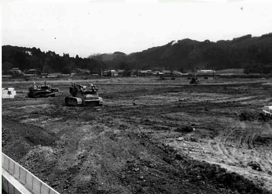
昭和51年頃の町民グラウンド造成工事（浅川町所蔵）
