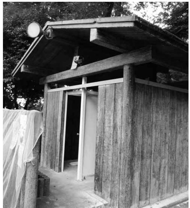
改修前トイレ
