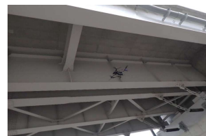
ドローンによる桁下高所の点検
