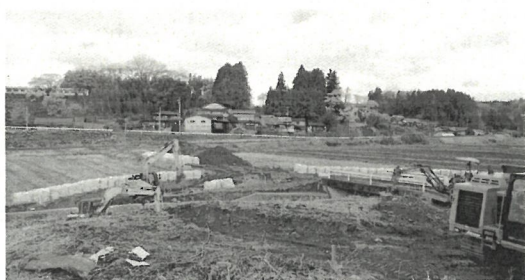
工事中の里白石木和田塚線
