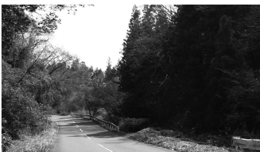
危険な日陰道路
