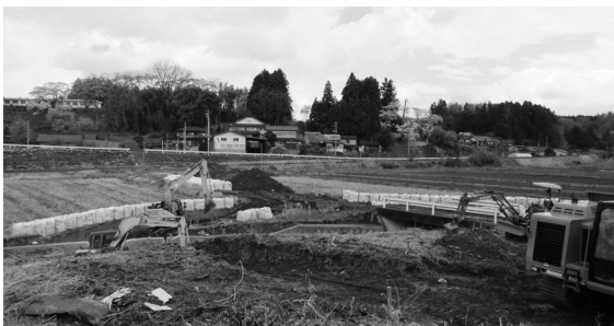
工事中の里白石木和田塚線
