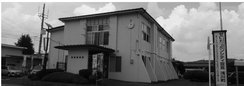
建築65年が経過した役場庁舎
