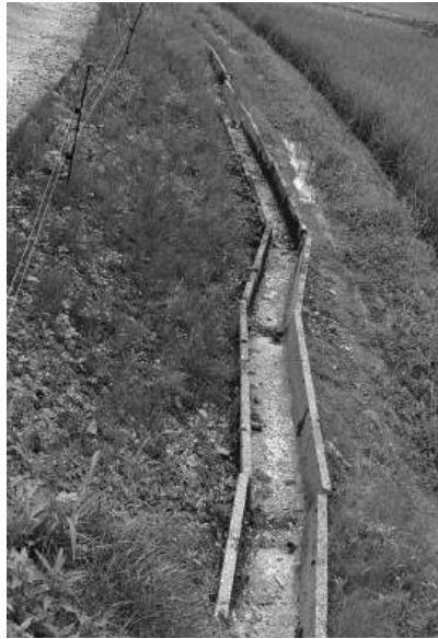
要望の多い水路改修
