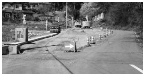
町道曲屋破石線
