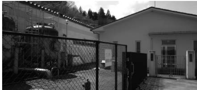
太田輪浄水場
