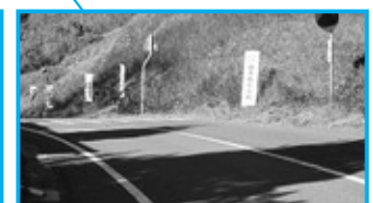
・路側帯が狭く、両方向からの上りの頂点であり、見通しも悪い。
