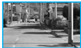
・歩道が狭く、電柱が邪魔になり、歩行者等が車道に入り込む。
