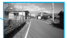
・道幅が狭く、車が高速で走行。
