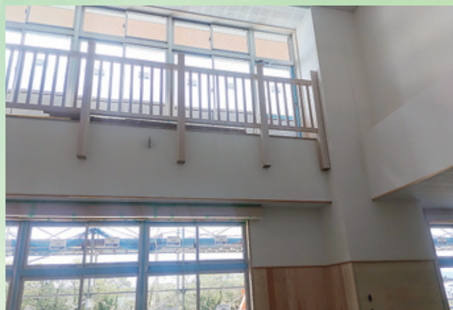
2階ラーニングcommons吹抜
