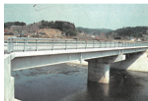
青砥橋改修工事完成
