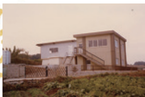
第一簡易水道拡張工事完成
