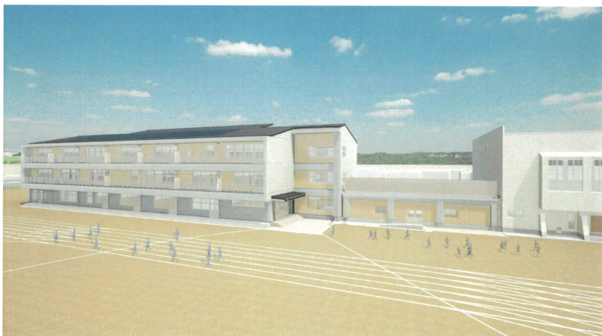
浅川町立浅川中学校校舎新築工事 令和6年8月完成予定
