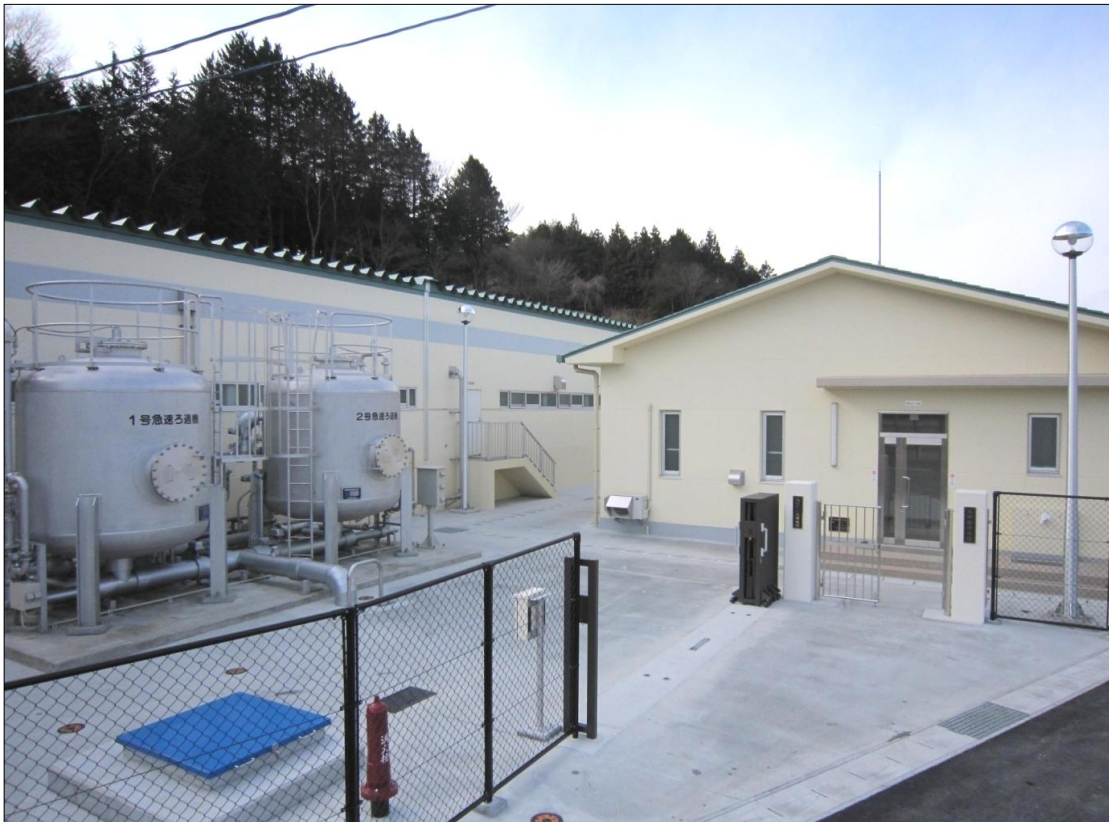
太田輪浄水場
